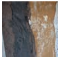
Riempimento con malta a base calce
