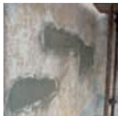
Interventi di ripristino a rappezzi
