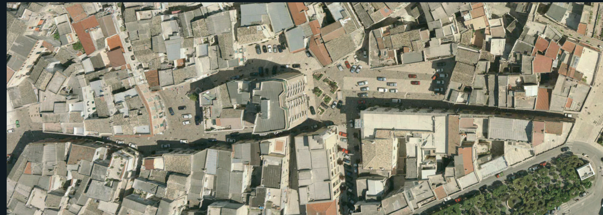
Veduta aerea di Via Matteotti
